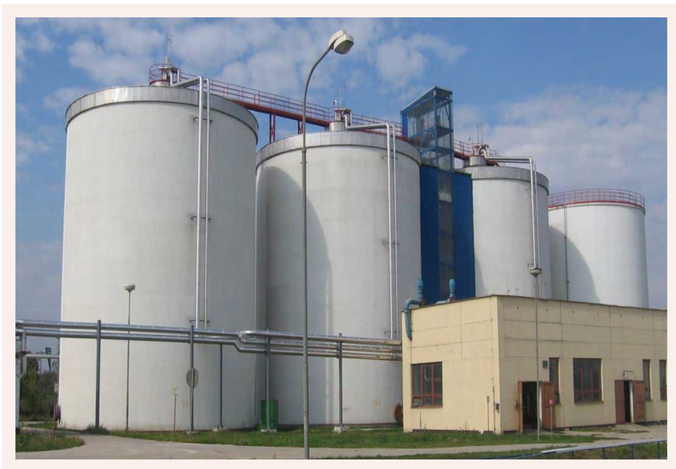
Obrázok 5.6: Vyhnívacie nádrže na ČOV Trnava – Zeleneč (foto: Bodík)
